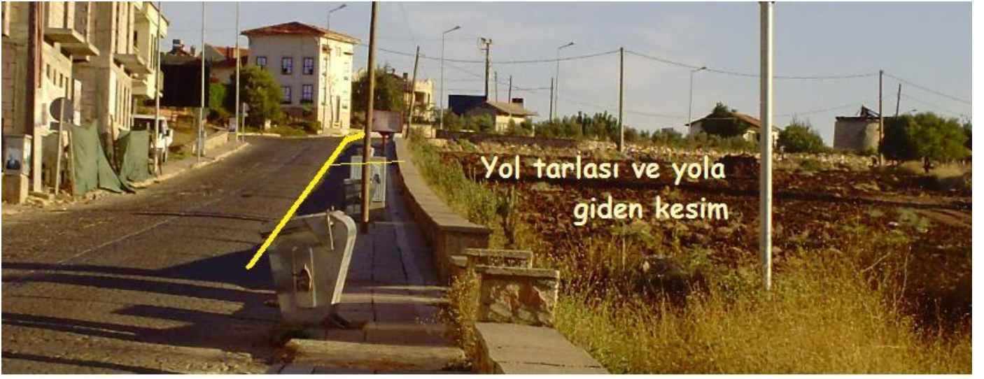
Foto B-7. Tarlanın yol için gasp edilen kısmı. İlk olarak, toprak yolun düzenlenmesinde, her defasında greyder çalışmalarında tarlanın içersine girilerek yol genişletildi, Her iki parke taş döşenme çalışmalarında tekrar tarlanın içersine girilmiştir. En son ise yaya yolun ve duvarın yapılmasında tekrar tarlanın içine doğru genişletme çalışması yapılmıştır. 2 ile 5 metreye kadar tarlanın içine girilmiştir.
