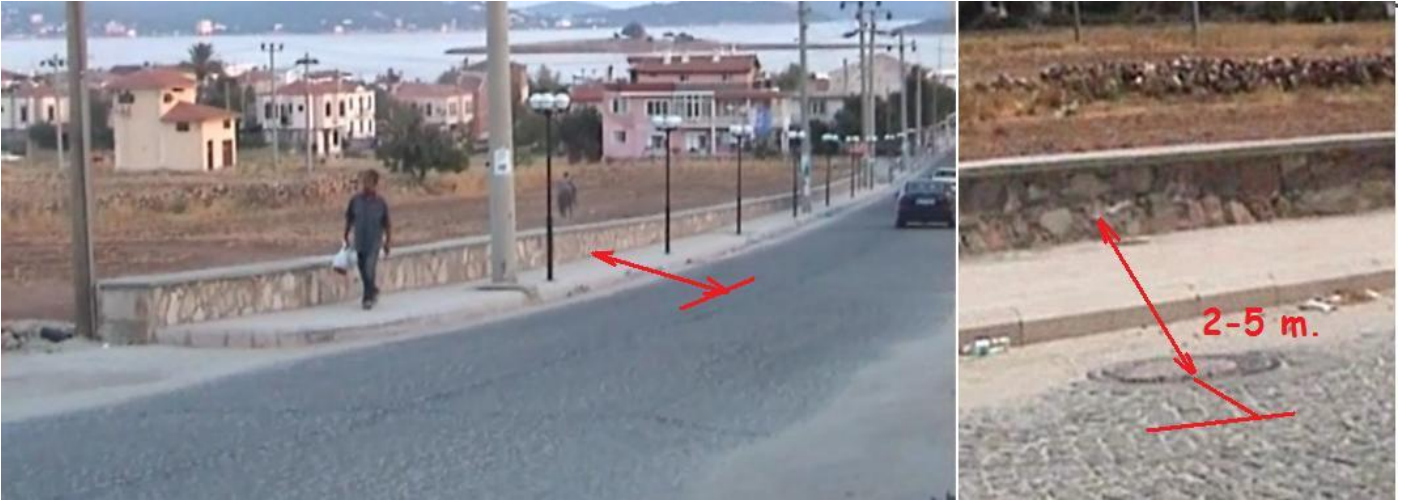
Foto B-6 Tarlanın yol için gasp edilen kısmı, yandaki fotoğrafta yolda görülen bu mazgallar, direkler eskiden tarlanın içersinden geçiyorlardı. Eski kuru taş duvarın bir metre kadar içersinde bulunuyorlardı
