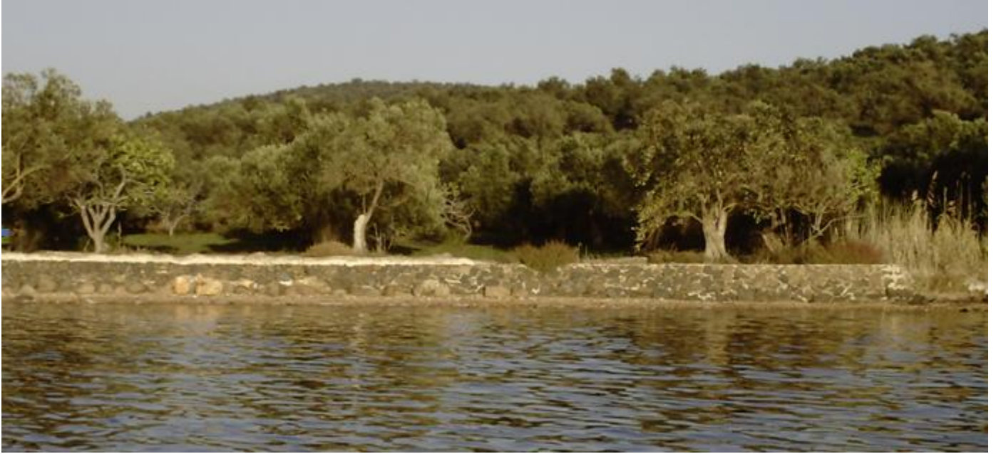
Foto- F-2. Toprak erozyonuna karşın tamir edilen ve sağlamlaştırılan mevcut duvarın denizden bir görünümü. (Ayvalık belediyesinin özden ailesine duvar tamiri için 1500 TL para cezası kesmiştir. Buna karşın Belediye cunda denizinin çöp, hafriyatla doldurulmasına, alan genişletilmesine ses çıkarmıyor, görmemezlikten geliyor. Cunda –Ayvalık liman denizinin her yıl artan kirliliğini görmüyorlar...
